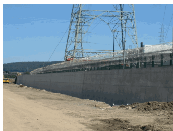
Mur de protection contre l'inondation – Tihange
