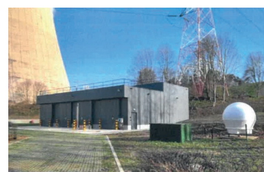
Centre Opérationnel de Repli – Tihange
