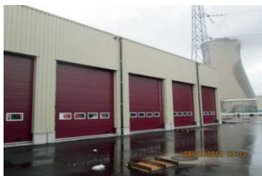
Bâtiment d'Ultime Secours - Doel
