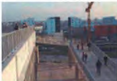
Ecole d'Architecture de Nantes (Lacaton &amp; Vassal)
