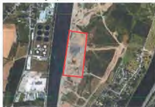
LIEGE: chantier pour Liège Trilogiport
