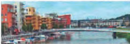
Hammarby Sjöstad : Le développement du réseau de chaleur, qui dessert l'ensemble du quartier, est alimenté par deux sources principales : la récupération d'énergie issue de la combustion des déchets de l'unité d'incinération et l'énergie issue du traitement des eaux usées, relayée par un système de pompes à chaleur.
