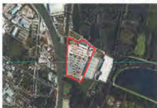
WILLEBROEK: terminal à conteneurs
